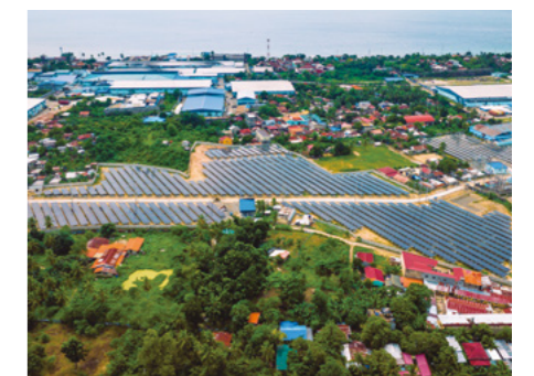
セブミツミ工場の太陽光発電システム
