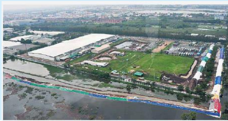
水が迫る中、現地従業員が昼夜問わず 土嚢を積み「奇跡の堤防」で工場を死守
