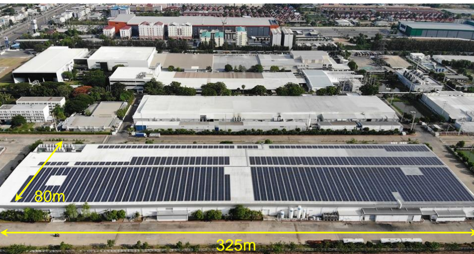
バンパイン工場
