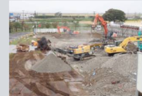
コンクリートを破砕した砕石を新棟の周りや舗装道路の路盤等に再利用（秋田事業所）
