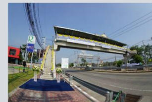
ロッブリ工場前の道路に建設された歩道橋 (タイ)
