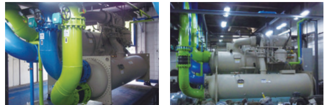
更新されたバンパイン工場の2機の冷凍機
