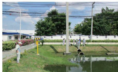
タイ・アユタヤ工場の放水路確認
